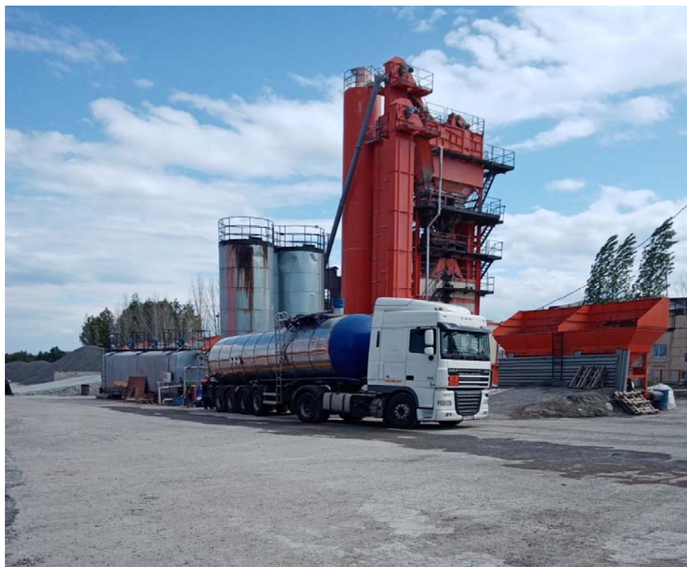
Рис. 2 Асфальтосмесительная установка КА-160
